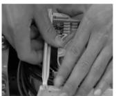
7.3.6 По окончании монтажа кассет установите их все в штатное положение (в виде блока кассет) и закрепите блок кассет черной нейлоновой лентой-«липучкой». Муфта FDC-HS-S4 обеспечивает возможность размещения в ней 2 кассет типа 2533.
