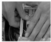
7.2.6 По окончании монтажа кассет установите их все в штатное положение (в виде блока кассет) и закрепите блок кассет черной нейлоновой лентой-«липучкой». Муфта FDC-HS-S4 обеспечивает возможность размещения в ней 2 кассет типа 2533.
