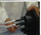
9.4 Установите на торец термоусаживаемой трубки между кабелями зажимную скобу. Убедитесь в том, что она установлена до упора. Скрепите кабели друг с другом кабельной стяжкой у концов алюминиевой фольги. Примечание: кабельные стяжки, во избежание их повреждения, должны быть расположены как можно дальше от термоусаживаемой трубки.
